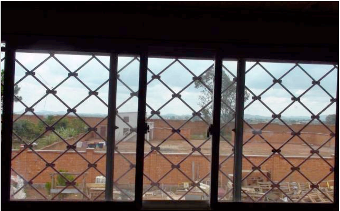
Fenêtre en alu avec grille de protection étage côté façade principale
