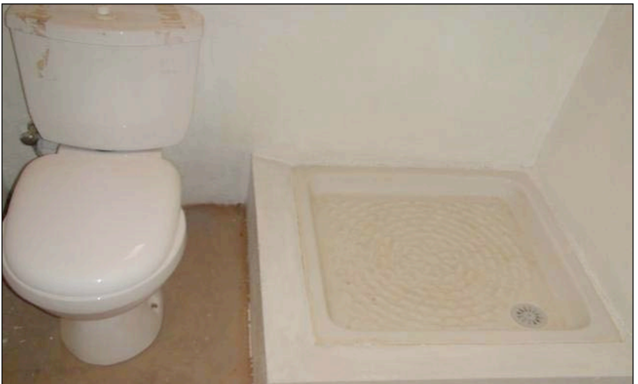
Salle d'eau dans la chambre d'accueil
