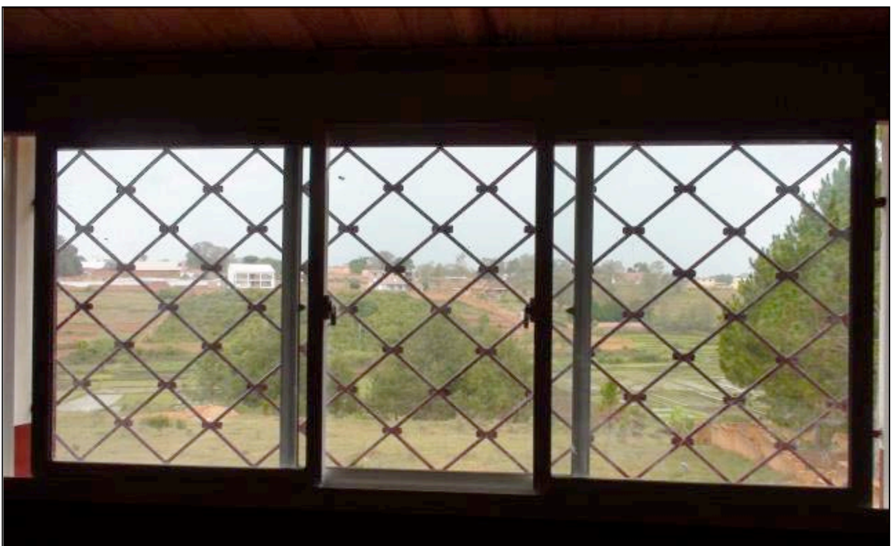
Fenêtre en alu avec grille de protection étage côté façade postérieure
